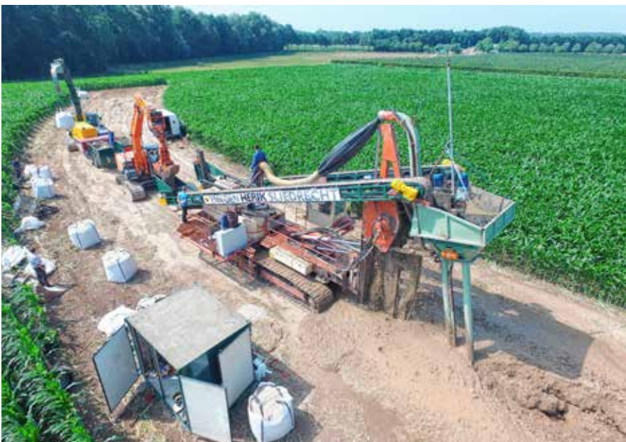
Na jaren van ontwikkeling heeft Van den Herik een machine ontwikkeld die weinig ruimte nodig heeft om een verticaal geotextiel aan te brengen.
