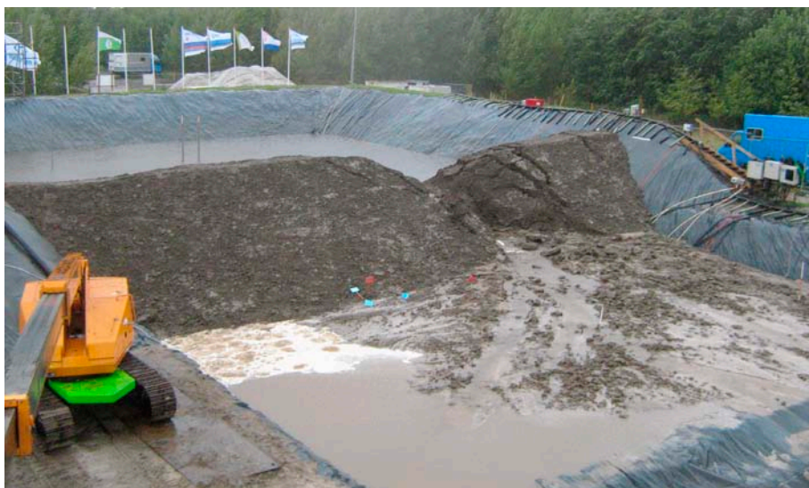
In oktober 2009 bezweek een dijk door een pipingproef zonder verticaal zanddicht geotextiel.
